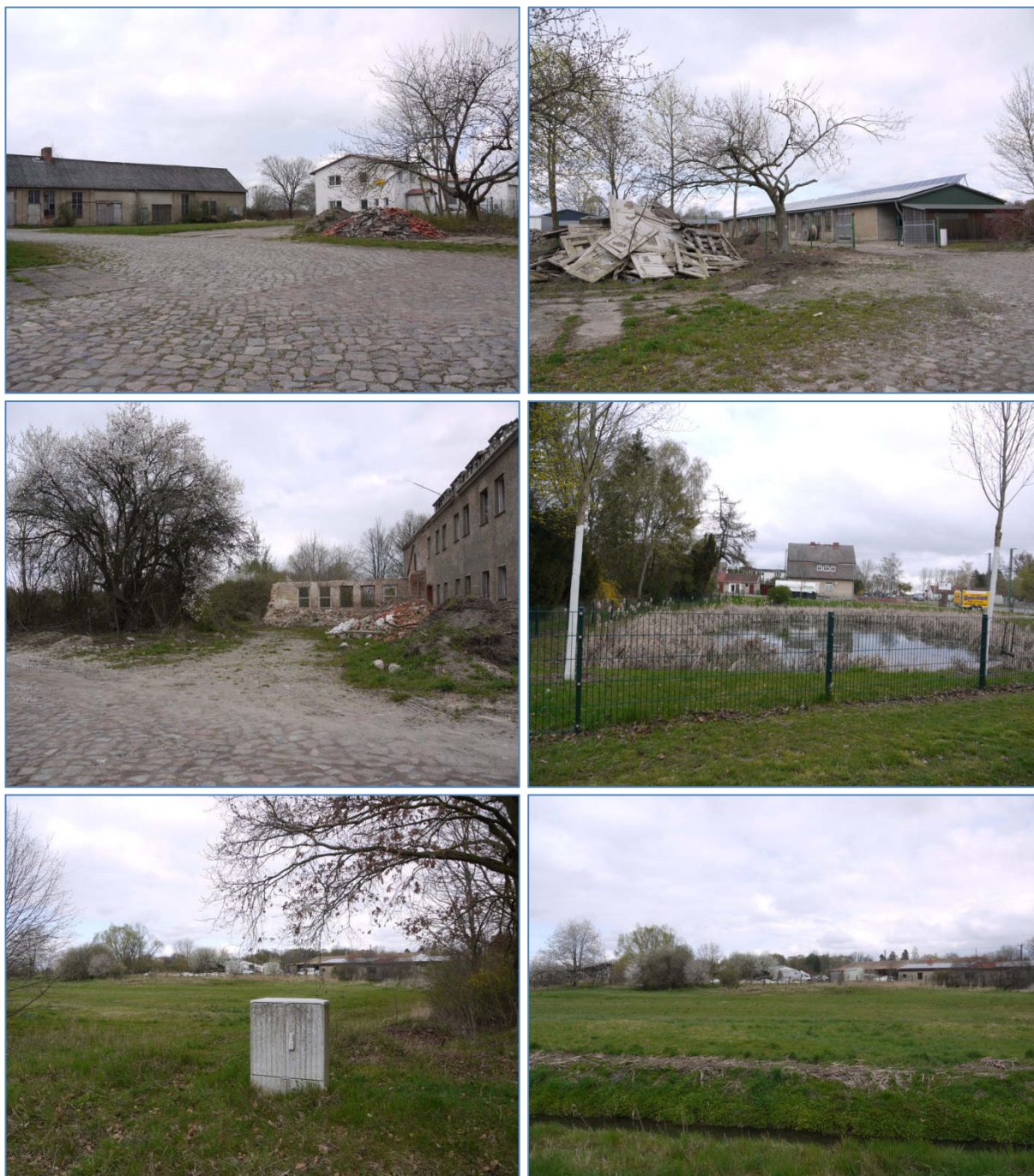
Abb. 4 bis 13 Ansichten des Planänderungsbereiches und des näheren Umfeldes.
