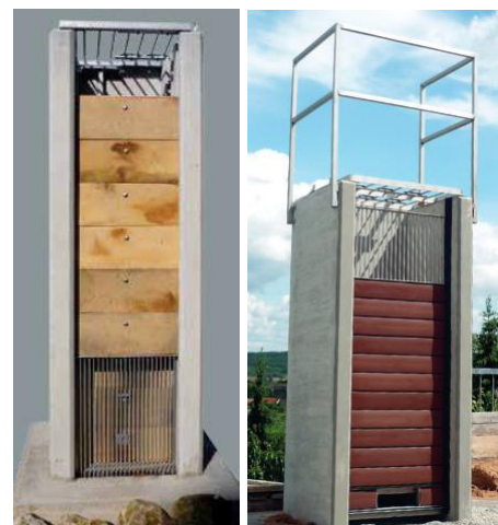
Abbildung 1.1: Gestaltungsvariante für ein Auslaufbauwerk (Mönch) (Quelle: http://www.riederundsohn.de )
