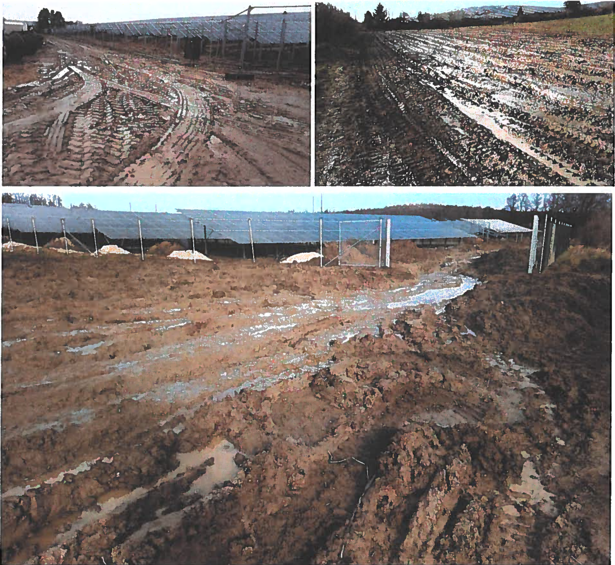
Foto 1-3: Befahrung ungeschützten Oberbodens bei ungeeigneter Witterung/Bodenfeuchte führt zu Schädigung des Bodengefüges und schränkt die Funktionsfähigkeit des Bodens ein
