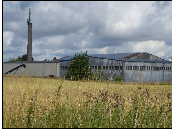
Abbildung 8: Westlich angrenzender Agrarbetrieb
