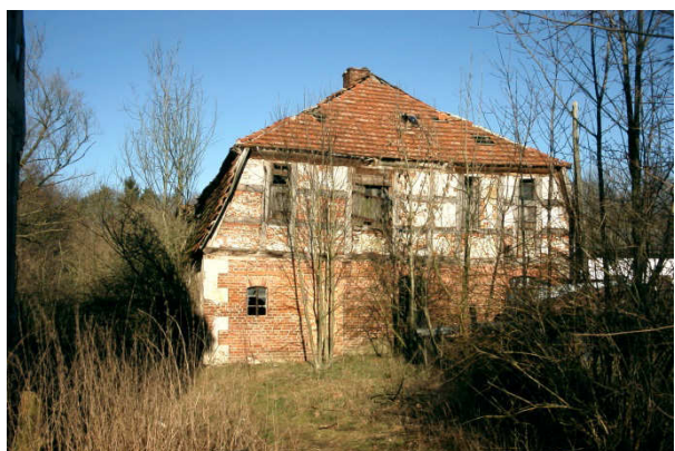
Abb. 4 Abgebrochenes altes Gutshaus (Stallspeicher)
