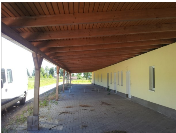
Abb. 6: Dachüberstand am Nebengebäude zur Montage der Rauchschnalben-Brutkreuze.
