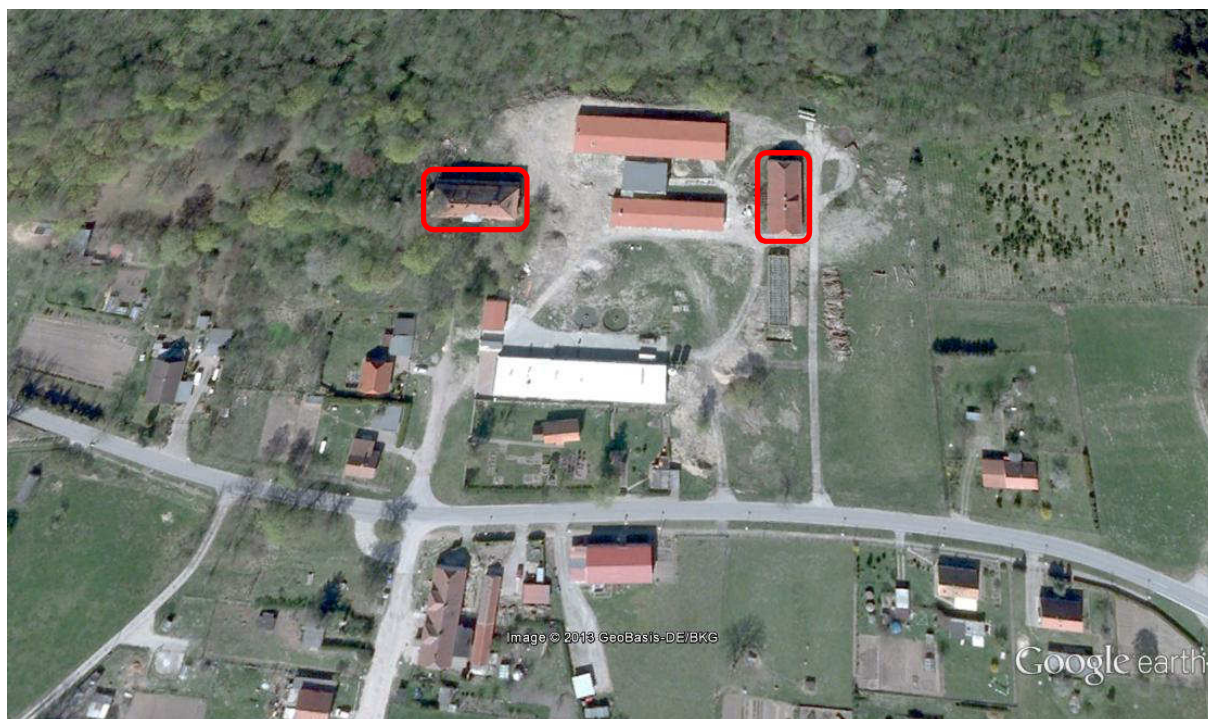
Abb. 1 Lage der Sanierungsobjekte Gutshaus (links) und ehem. Pferdestall (rechts) in Kuntzow
