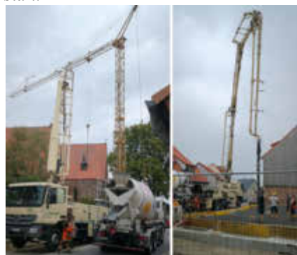
Die Bodenplatte wird gegossen.
