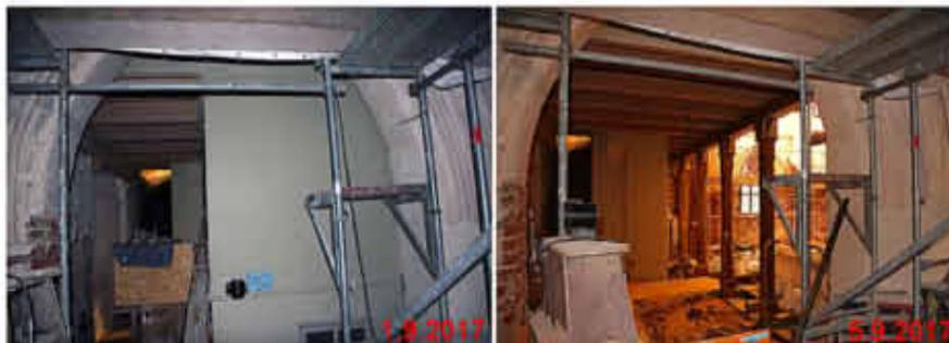
Nach dem Rückbau der Verkleidungen unter der Orgelempore erwartet die Besucher beim Hineingehen in die Behrenhoffer Kirche ein ganz neuer Raumeindruck. Zurzeit ist das Innere eine einzige Baustelle. Elektroleitungen für Licht, Tontechnik und Heizung werden verlegt, die Wandflächen im Kirchenschiff werden neu verputzt, ebenso die Gewölbe und Wände im Seitenschiff. Die Fußböden werden erneuert und ergänzt. Mit Beginn des neuen Kirchenjahres, ab Advent, gibt es dort wieder regelmäßig Gottesdienste.
